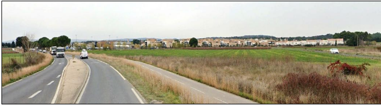
VUE 01 : Le front bâti dense du nouveau quartier St Estève depuis la RD5.
